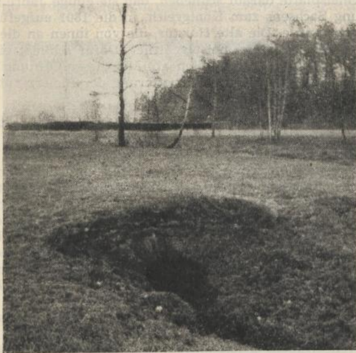
Bild 107. Mundloch vom Anna-Stollen an der Mulde unterhalb von Rothenfurth-Großschirma (Photo: 1953)
