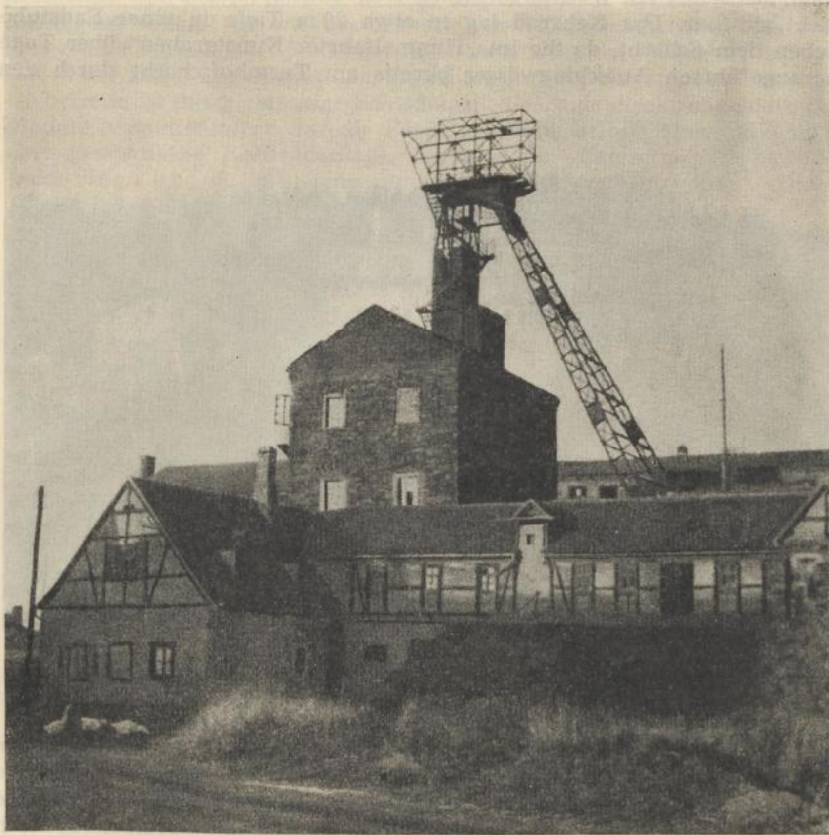
Bild 9. Förderthurm und ehemaliges Mannschaftshaus vom Abrahamschacht bei Freiberg (Blick von Süden, Photo: 1952)
