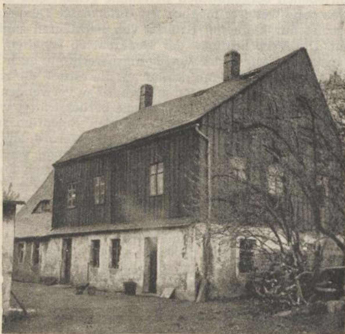
Bild 122. Die z. T. aufgestockte Hofseite vom Kurfürst Johann Georg Stollen-Huthaus in Zug bei Freiberg (Photo: 1951)
