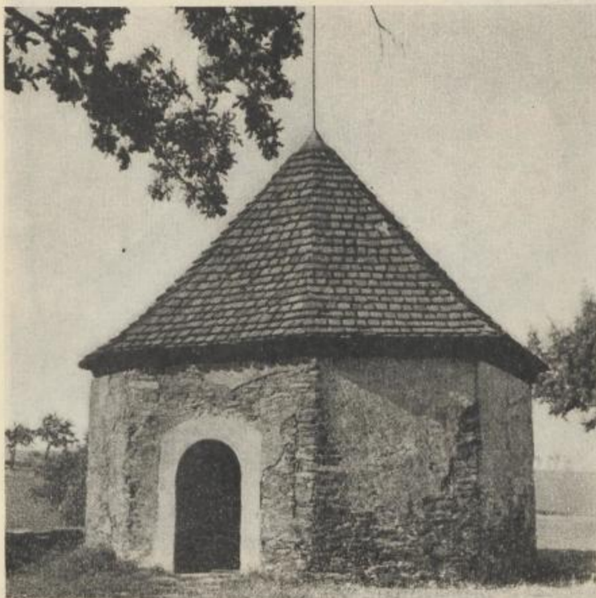
Bild 62. Pulverturm der Grube Alte Hoffnung Gottes in Kleinvoigtsberg (Photo: 1951)
