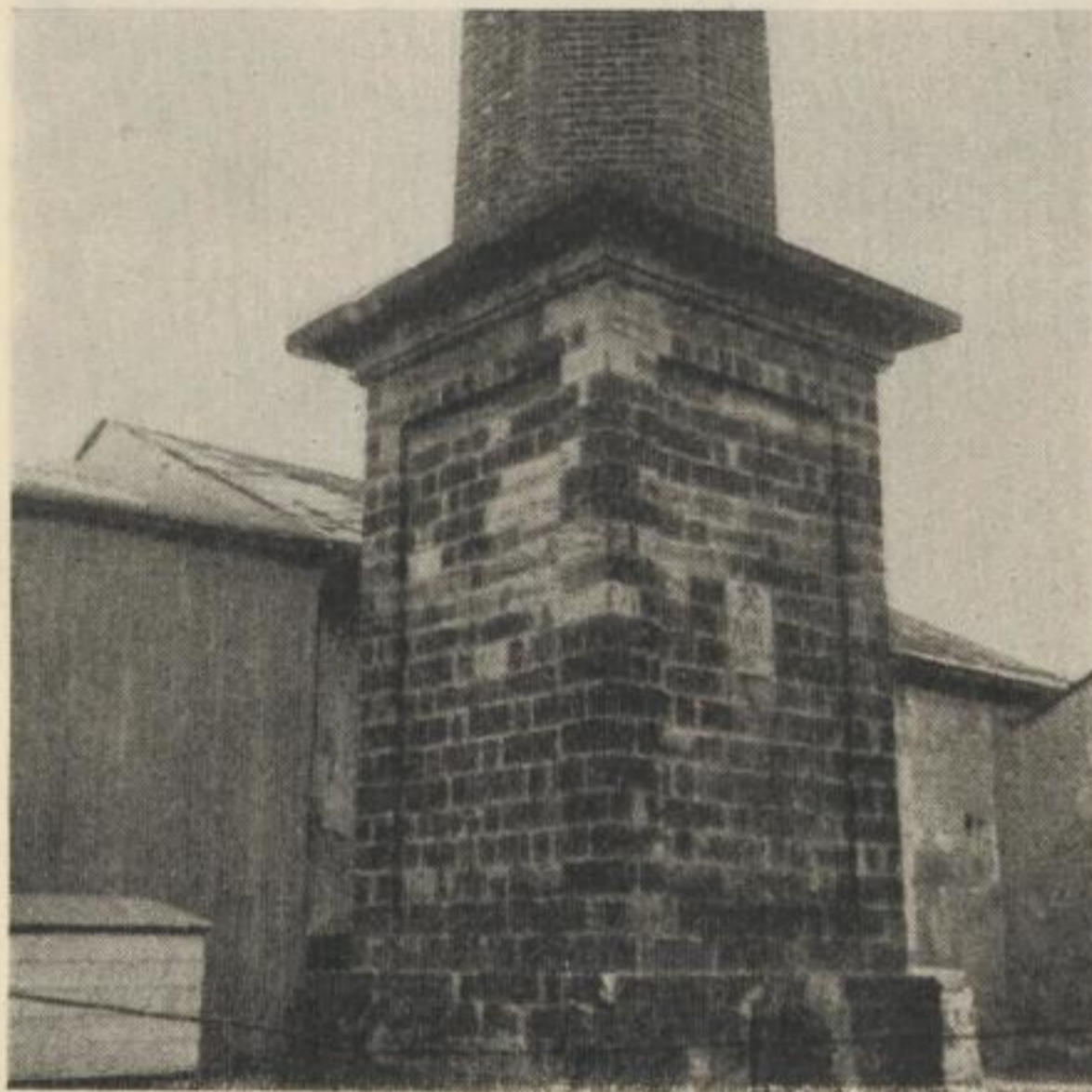
Bild 20. Schornsteinsockel der Dampfförderanlage der Grube Alte Hoffnung Gottes in Kleinvoigtsberg (Photo: 1952)
