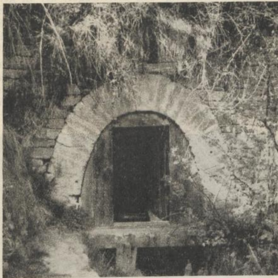
Bild 111. Oberes Mundloch der Felsenbach-Rösche, 1. Mdl. der Grabentour bei Krummenhennersdorf (Photo: 1953)
