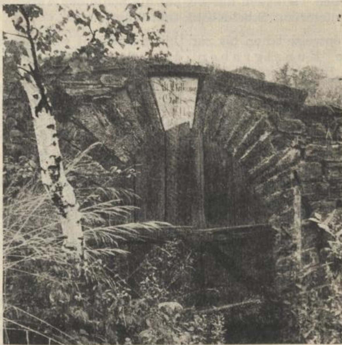
Bild 98. Aufschlagröschen-Mundloch der Grube Alte Hoffnung Gottes in Kleinvoigtsberg (Photo: 1951)
