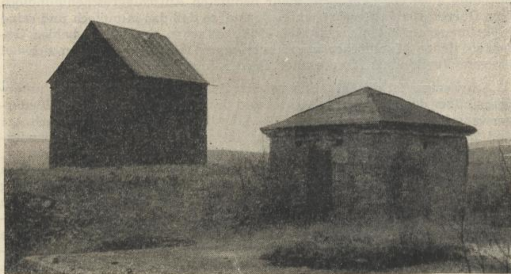
Bild 124. Treibehaus und Pulverturm vom 7. Lichtloch des Rothschnöberger Stollens bei Halsbrücke vor der Wiederherstellung (Photo: 1951)
