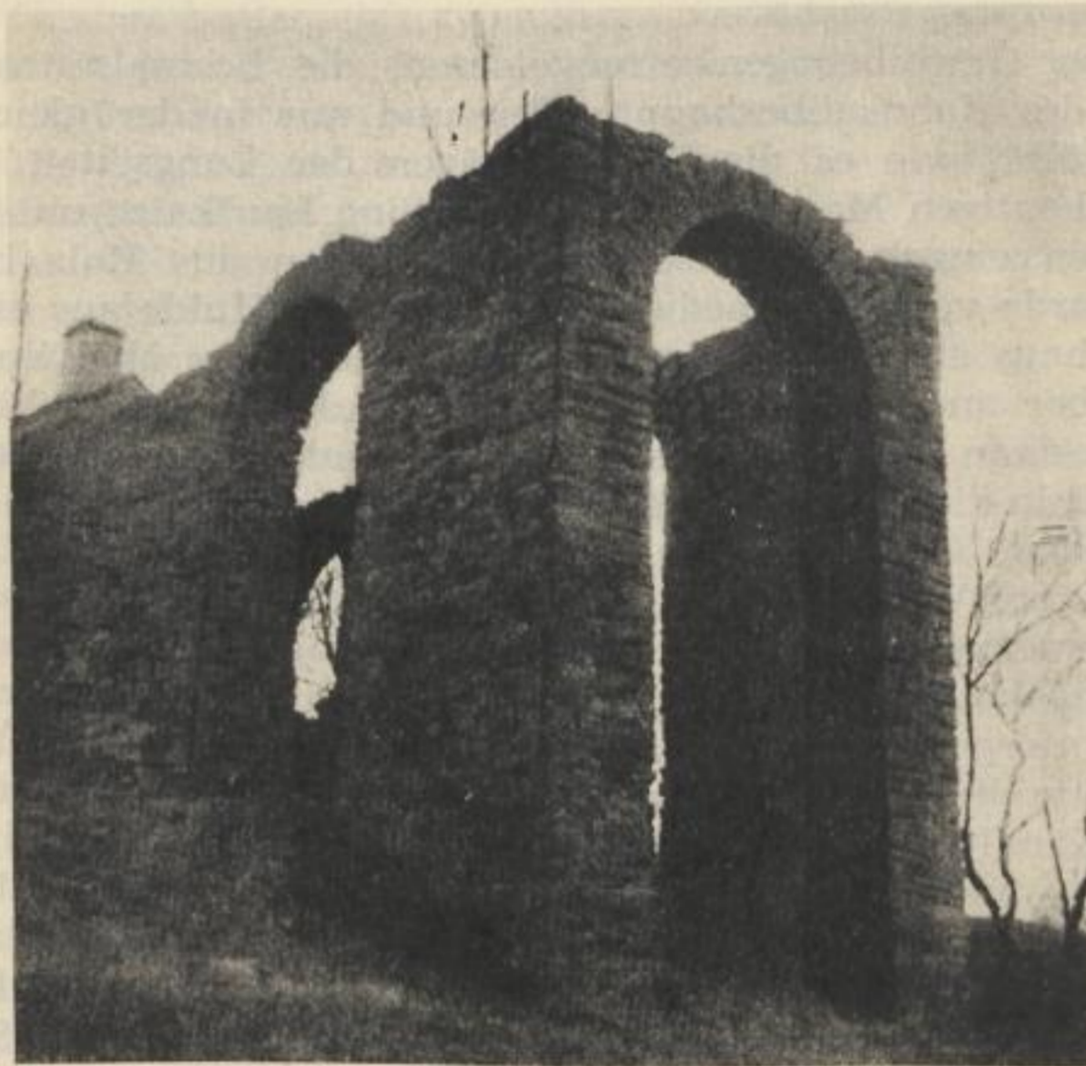
Bild 87. Ruine des Kahnhebehauses bei Halsbrücke (Photo: 1951)
