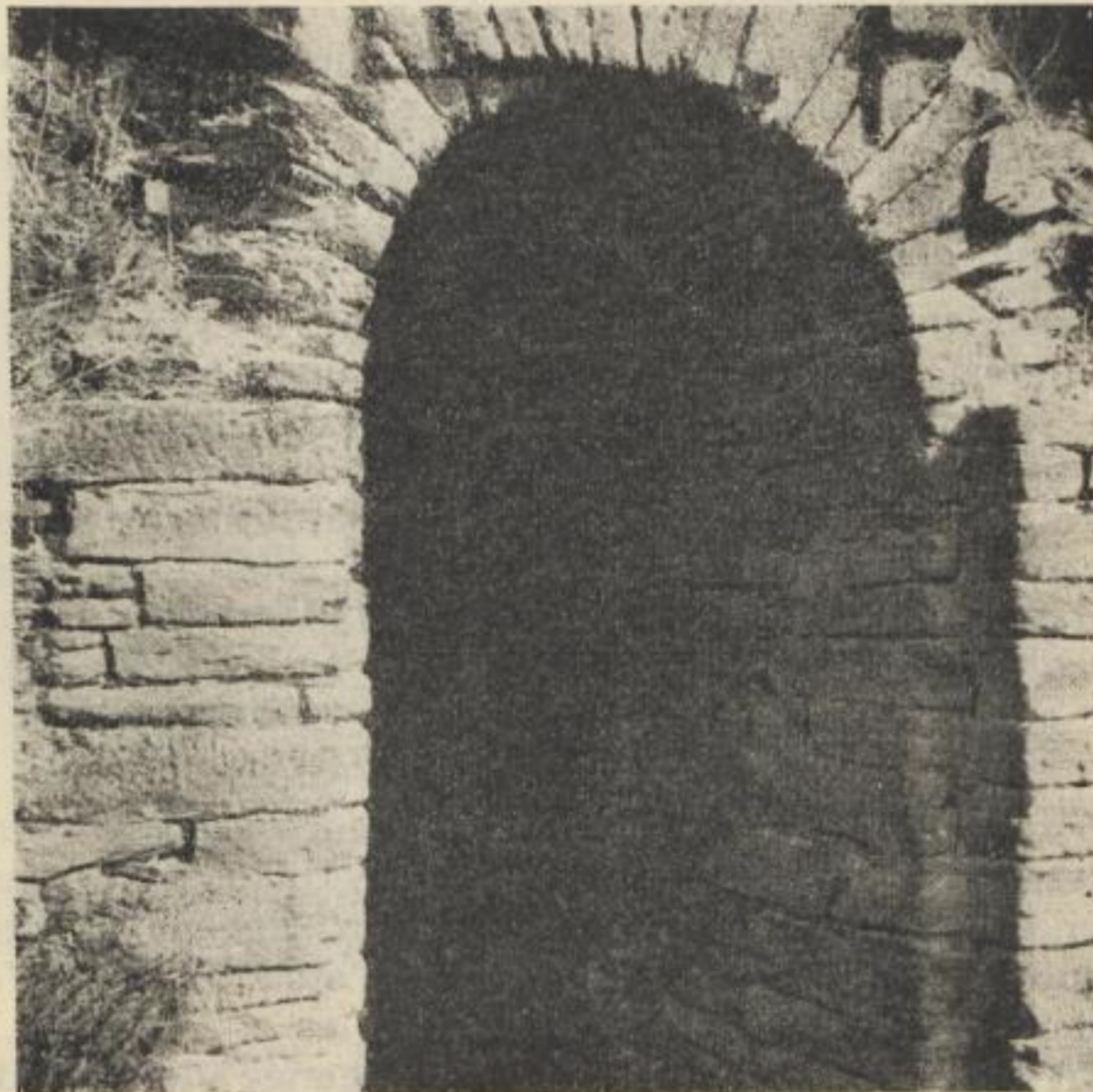
Bild 22. Treibhaus-Fundamente vom 6. Lichtloch des Rothschnberger Stollens bei Krummenhennersdorf (Detailaufnahme) (Photo: 1953)
