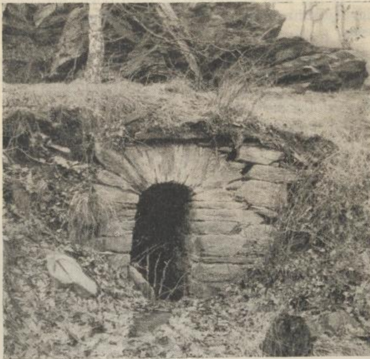
Bild 100. Mundloch vom Schwarzen Mittag Stollen im Münzbachtal bei Rothenfurth (Photo: 1951)
