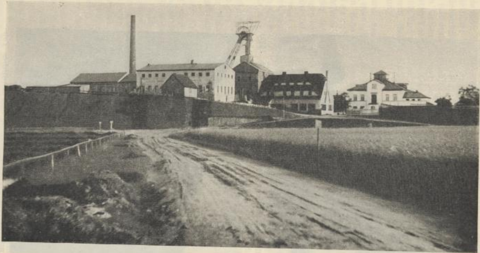
Bild 80. Übertagegebäude vom Abrahamschacht der Himmelfahrt Fdgr. bei Freiberg. Von rechts nach links: Verwaltungsgebäude, Bergschmiede, Förderturm, Scheidebank, Kesselhaus mit Schornstein. Vor der Scheidebank „Rollturm“, Erzrolle und nördliches Tunnelmundloch (um 1900). (Photo: Stadt- und Bergbaumuseum Freiberg)
