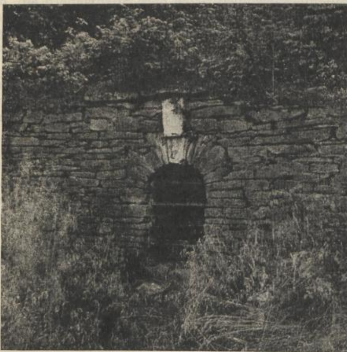
Bild 104. Mundloch vom Alten Tiefen Fürstenstollen im Muldental am Roten Graben oberhalb von Tuttendorf (Photo: 1951)
