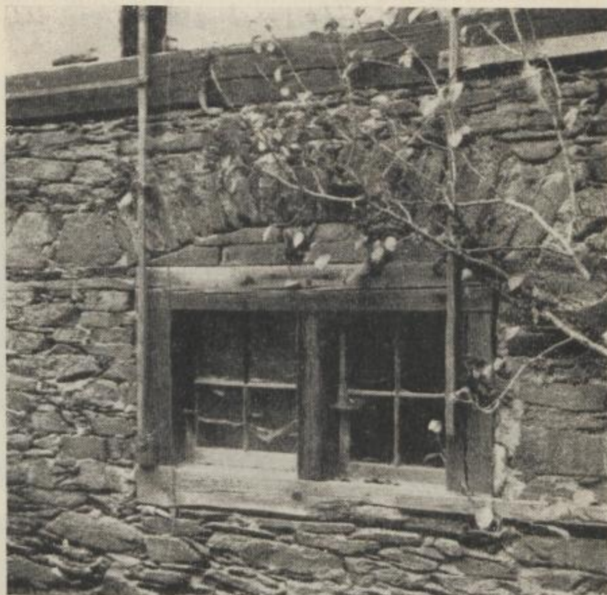
Bild 75. Fenster im Südgiebel der Stoßherdwäsche der Grube Dorothea (am Unverhofft Segen Gottes Stollen) in Oberschöna (Photo: 1953)
