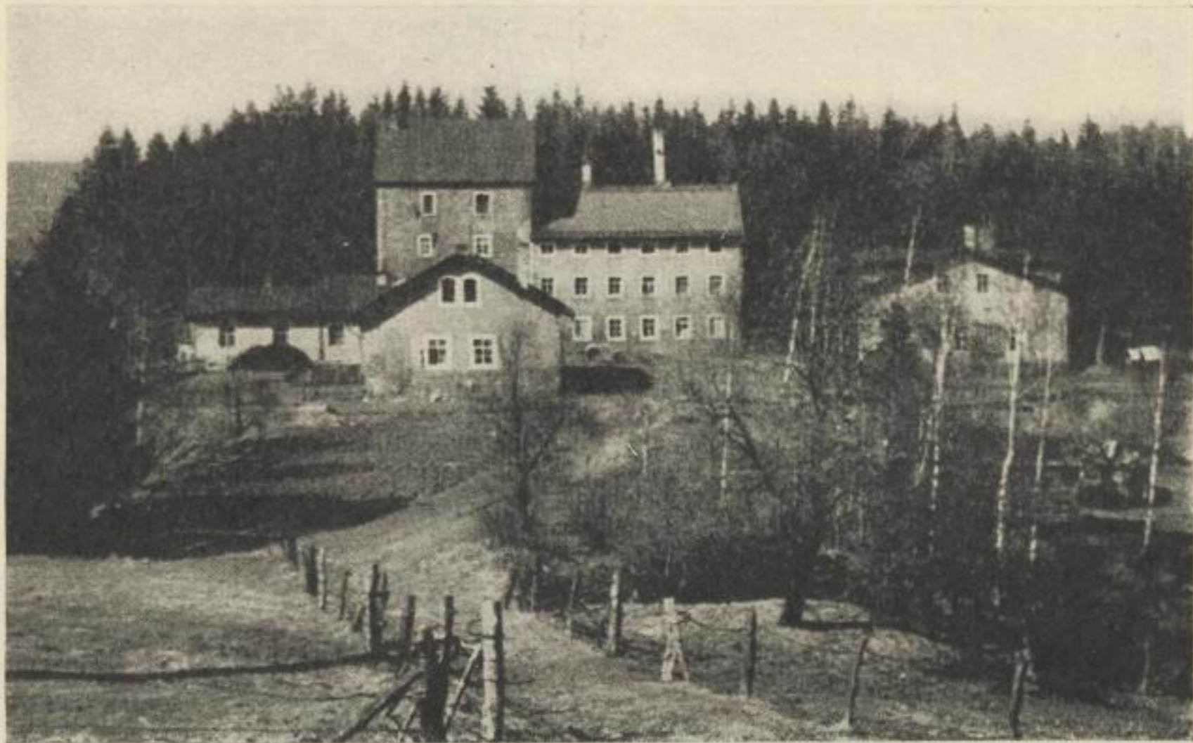
Bild 10. Treibehaus und übrige Tagegebäude der Grube Gesegnete Bergmanns Hoffnung bei Obergruna (Photo: 1955)
