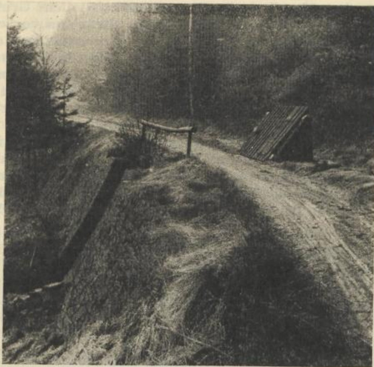
Bild 96. Überlaufrinne am Roten Graben oberhalb von Tuttendorf (Photo: 1957)
