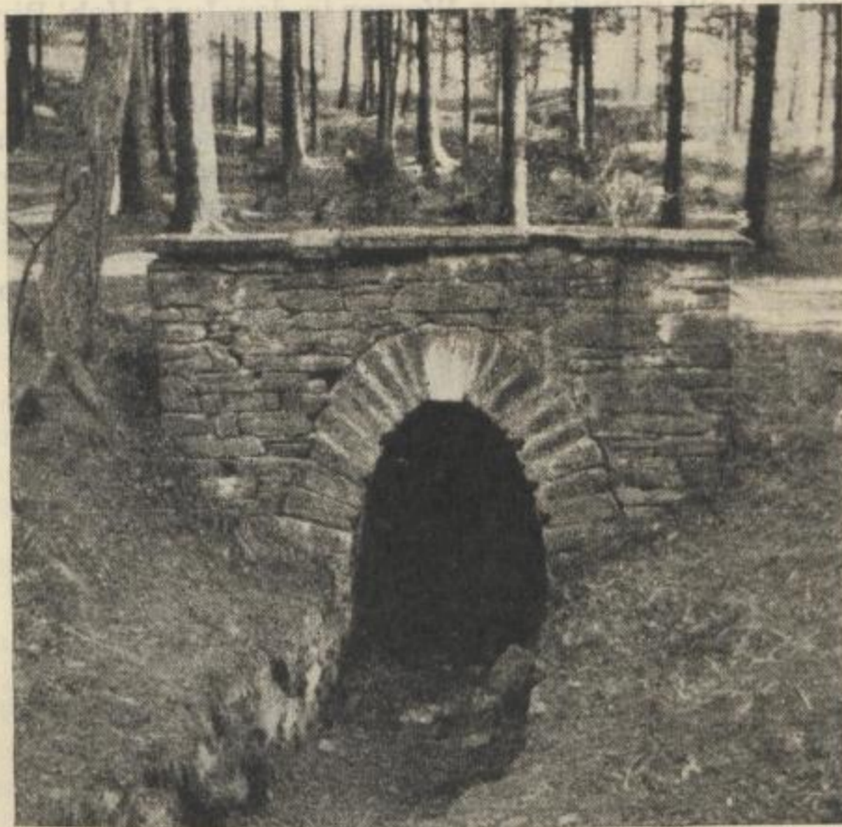
Bild 112. Unteres Mundloch der Rösche am 5. Lichtloch, 6. Mdl. der Grabentour bei Reinsberg (Photo: 1953)
