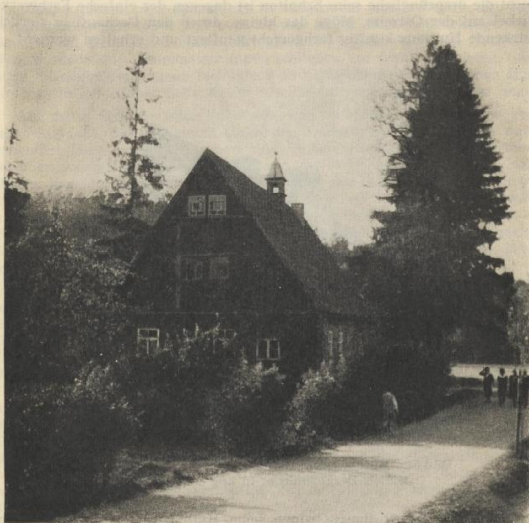
Bild 54. Huthaus Neue Hoffnung Gottes bei Bräunsdorf (Photo: 1953)
