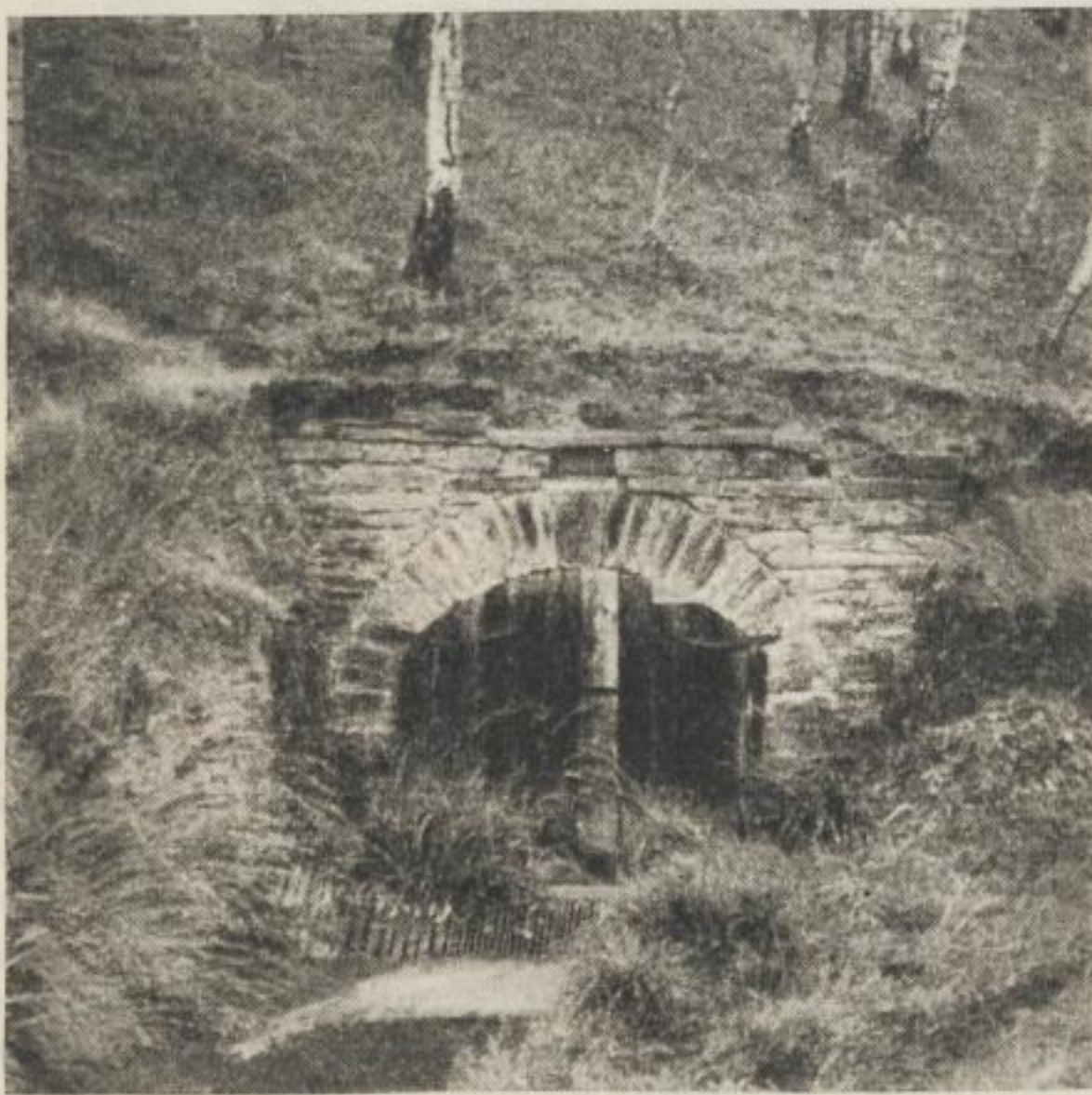
Bild 109. Röschenmundloch am Roten Graben bei Halsbrücke (Photo: 1951)
