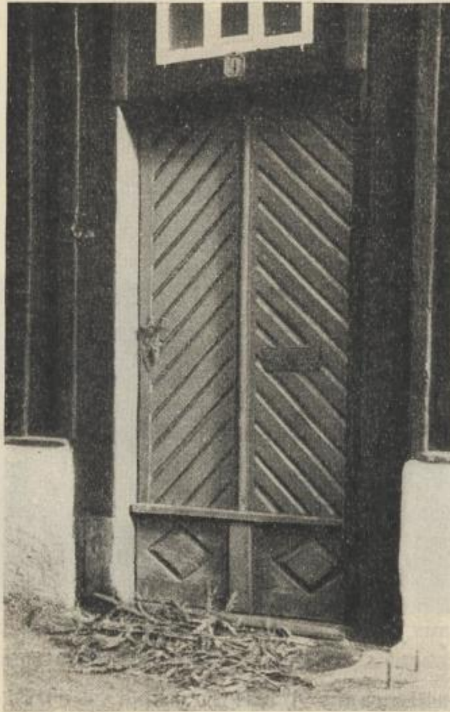
Bild 40. Haustür des Huthauses vom Verträgliche Gesellschaft-Stollen, Muldental bei Freiberg (Photo: 1957)
