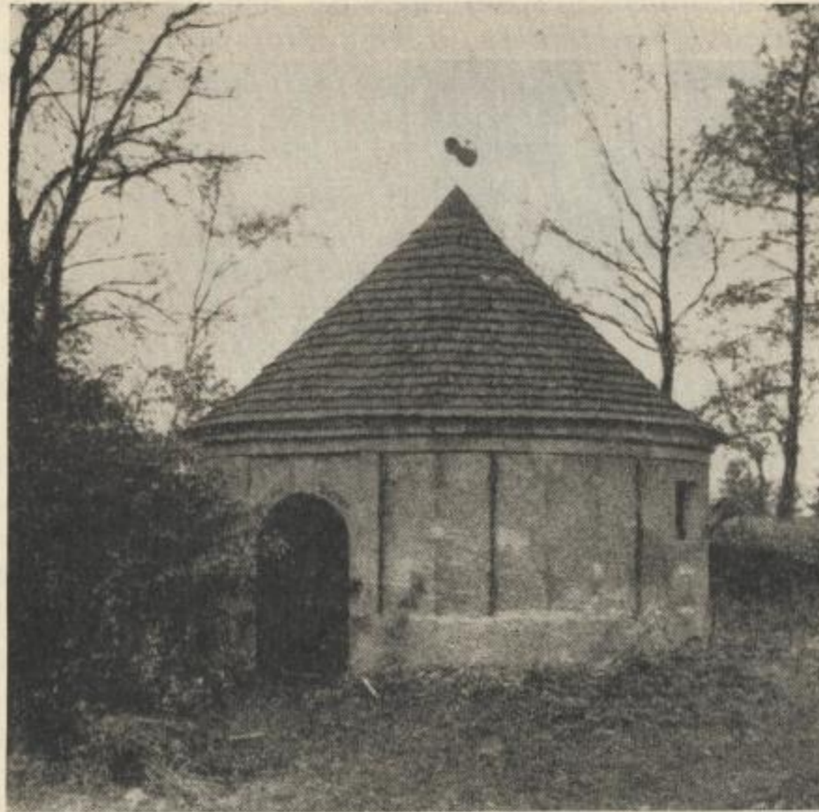
Bild 63. Pulverturm der Grube Churprinz bei Großschirma (Photo: 1953)
