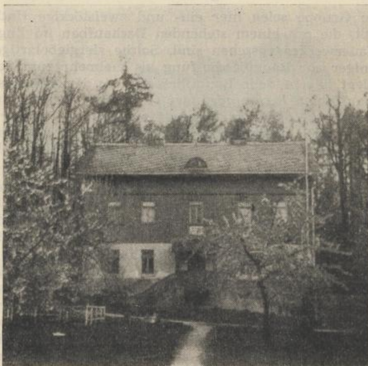
Bild 52. Huthaus vom Rothsönberger Stollen am 4. Lichtloch in Reinsberg (Photo: 1953)
