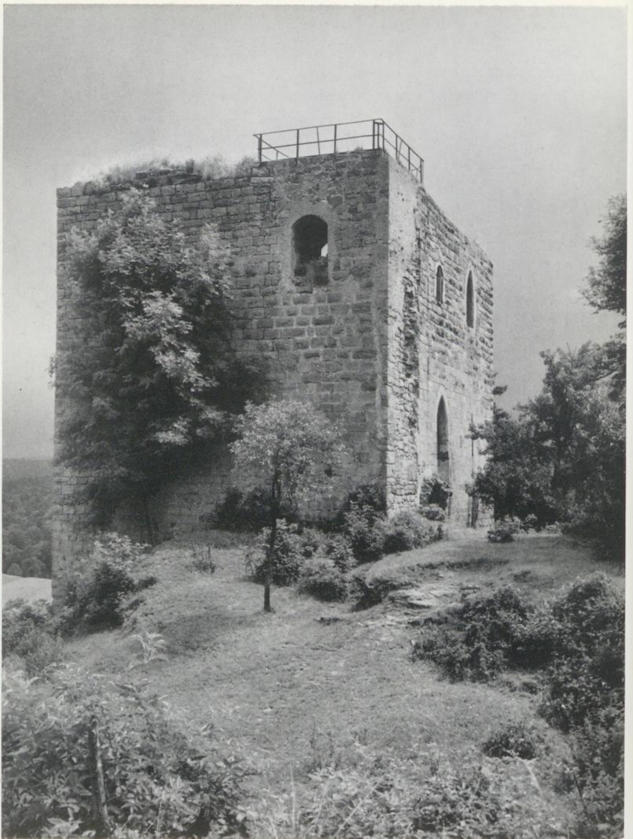
58. HELFENBERG Hochliegender Zugang in der Mitte der rechten Seite
