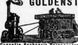
**Dresch-Maschinen für Hand-, Göpel- u. Dampf-Betrieb.**
