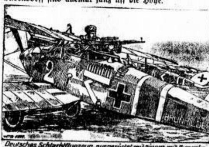
Deutsches Schlachtflugzeug, ausgerüstet mit einem mit Fernrohr-Maschinengewehr, Handgranaten und Signalpatronen.
