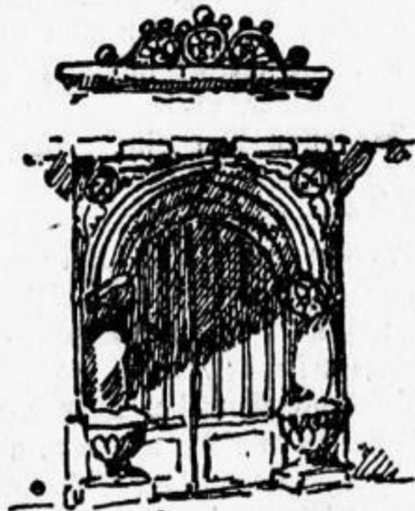
Haustür des früheren Gebäudes, jetzt in der Mauer im Marktgäßchen.
