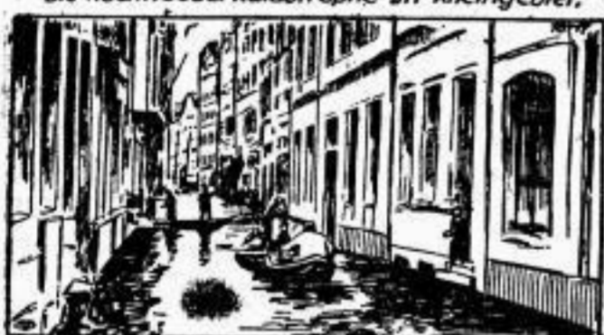
Köln-Mülheim, wo infolge Dammbrochs das Wasser die Strassen überschwemmte.
