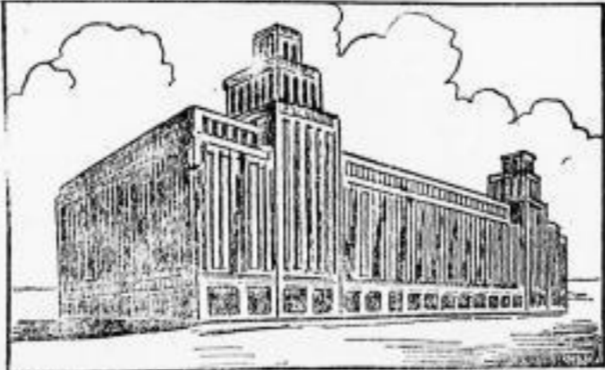
Das neue Warenhaus für Berlin, das am Hermann-Platz in Neukölln errichtet wird und rund zehn Millionen Mark Baukosten verschlingen soll. Die Bauarbeiten, die in diesen Tagen beginnen, werden etwa 2000 Arbeitern Beschäftigungsmöglichkeit geben. Das gewaltige Kaufhaus wird etwa 5000 Angestellte beschäftigen.
