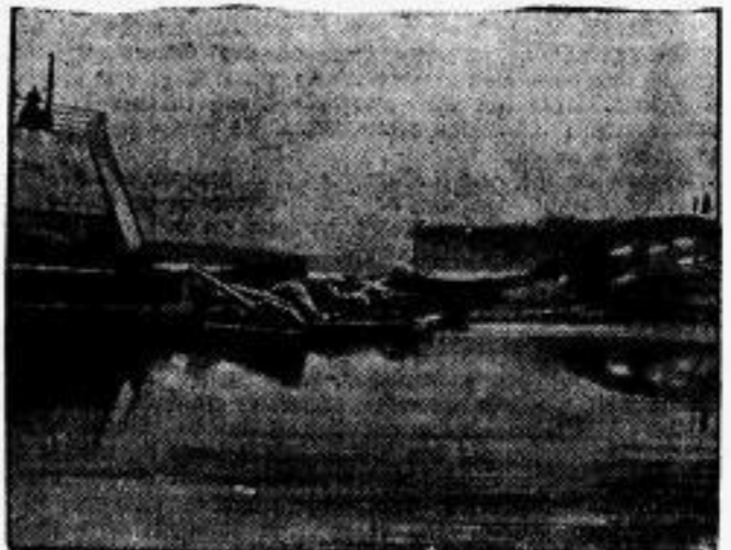
Der Staubeckenbruch bei Straßforth.
