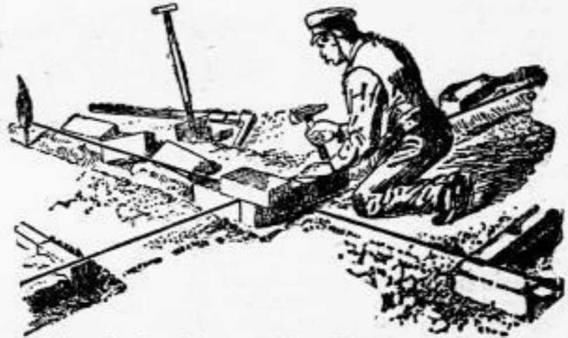
Abbildung 3. Das Setzen von Mauersteinen nach der Schnur.
