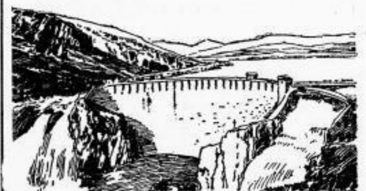
DER „ROOSEVELT-STAUDAMM“ AM APACHE-TRAIL IN ARIZONA, NORDAMERIKA
