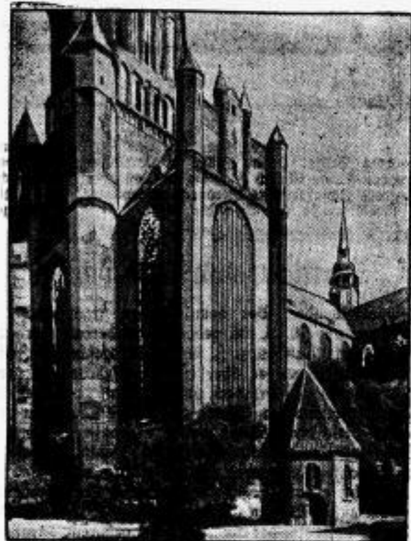
Die Stralsunder Marienkirche baufällig.
