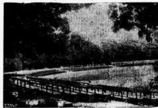
Hier wird das Befreiungsspiel aufgeführt. Unter Bild zeigt den in der Festigung begriffenen neuen Festplatz in Wiesbaden unter den Linden, auf dem das Befreiungsspiel aufgeführt werden wird.
