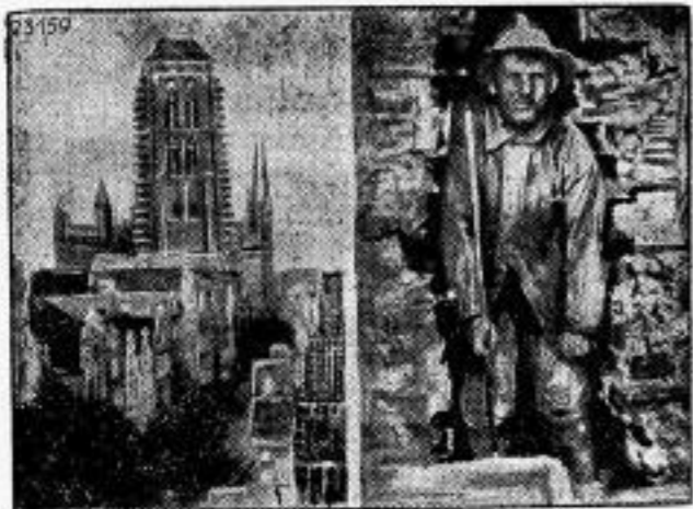
Einwurfgefahr für die Marienkirche in Danzig. In der mittleren Höhe des Turms der altgewaltigen St.-Marien-Kirche in Danzig sind Risse entstanden, die an der Nord- und Südseite so breit sind, daß sie einem Mann Raum bieten. Der berühmte Bau, der in seinem Inneren kostbare Kunstgegenstände birgt, muß als gefährdet gelten, wenn nicht die Restaurierung mit größter Mittel als den vorhandenen vorgenommen wird. Unser Bild zeigt die gefährdete St.-Marien-Kirche in Danzig und rechts einen der kassenden Risse in der mittleren Höhe des Turmes.
