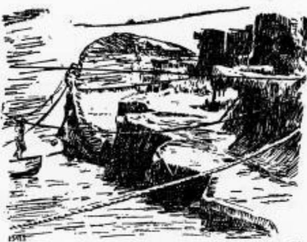
Die Hebung des Kreuzers „Hindenburg“ in Scapa Flow. Der deutsche Kreuzer konnte nach langen Vorarbeiten schließlich gehoben werden, Strandete jedoch erneut, als er abgeschleppt werden sollte.
