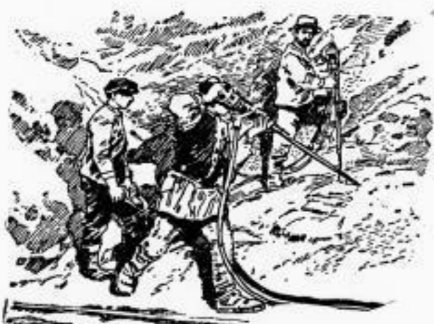
Wie in andern Bergwerken wird zur Lösung des Steinsalzes der elektrische Bohrer benutzt.
