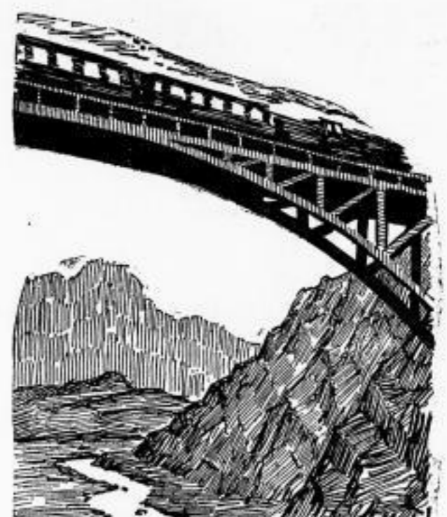
Auf kühnen Brücken donnert heute der Express über Schluchten u. Täler
