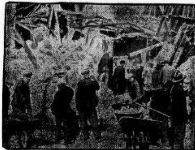
Bergungsarbeiten an der Trümmerstätte.
