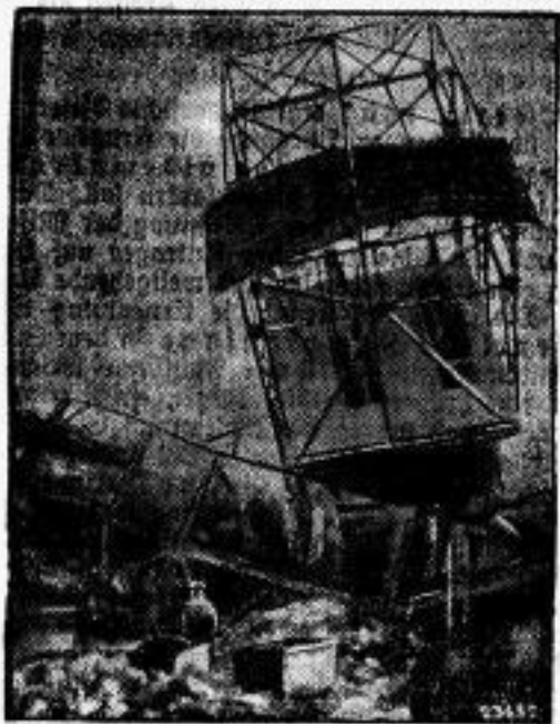
Das vollkommen zerstörte Schachtfördergerüst.
