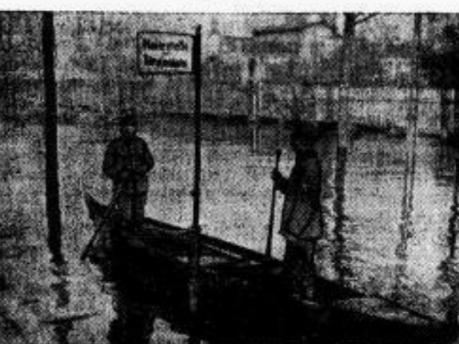
Die Reichswehr baut Notbrücken durch die überschwemmten Straßen Frankfurts.
