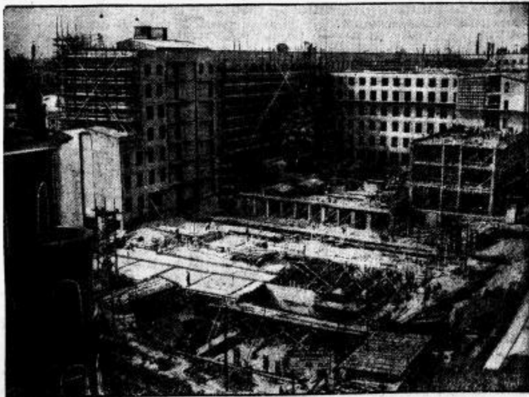
Vom Bau des Reichsluftfahrtministeriums. Ein Einblick in die Neubauarbeiten von der Ecke Wilhelmstr. — Prinz-Albrecht-Strasse aus gesehen.
