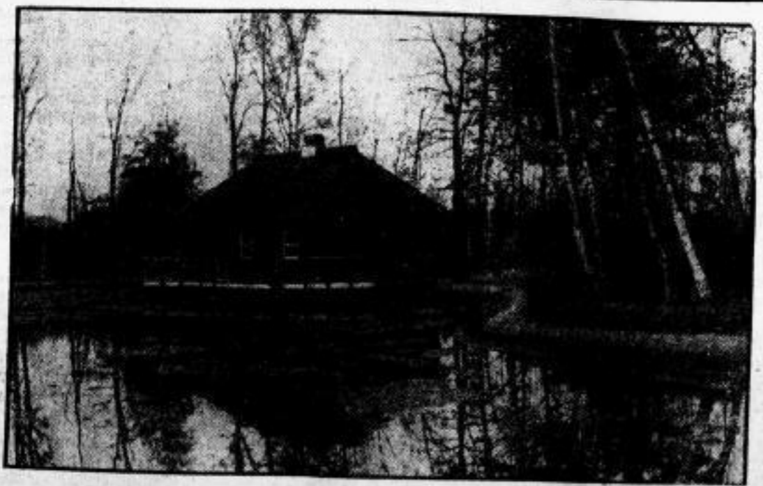
Außenansicht der „Sauna“, der finnischen Dampf- badestube, im Olympi- schen Dorf bei Döberitz.
