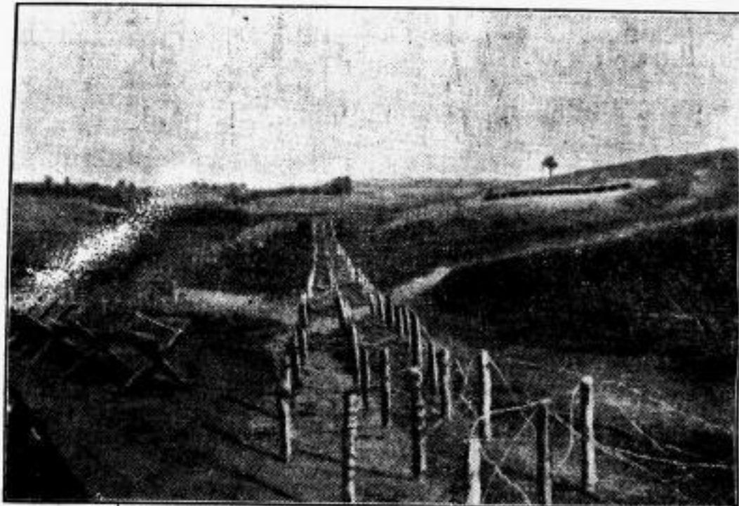
Start ausgebaute russische Nachhutstellung.
