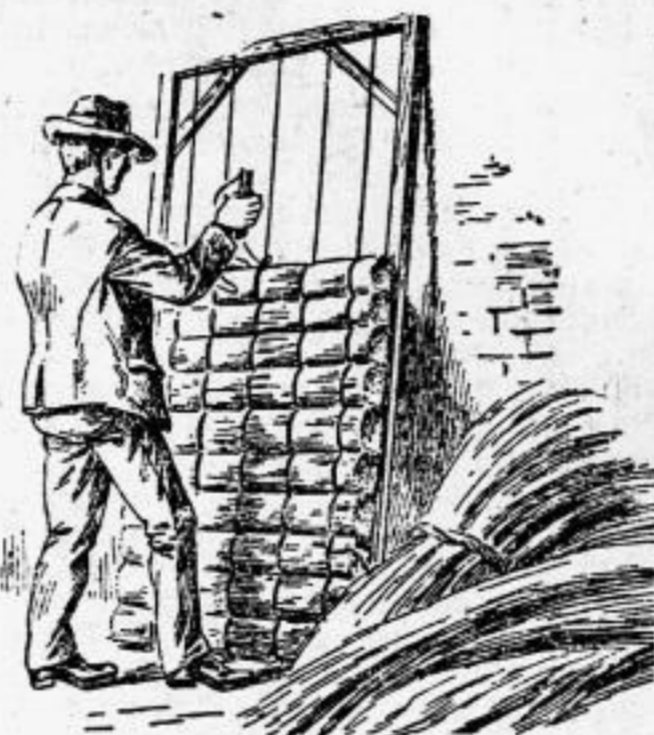
Abbildung 3 Wie die Strohecke gearbeitet wird. Der Holzrahmen steht fast senkrecht an der Wand
