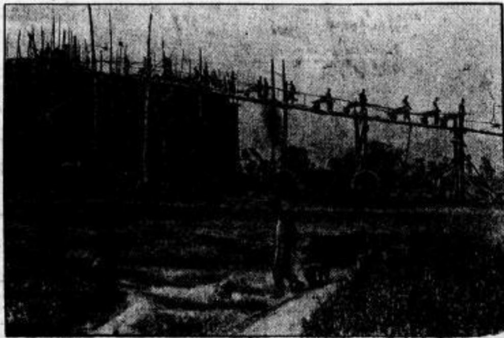
wegen kommunistische Überfälle. Bau einer Wehrmauer im westlichen China in der Provinz Kansu. Vielfach werden jetzt in China derartige Schutzmauern gegen die umherstreifenden kommunistischen Horden errichtet.
