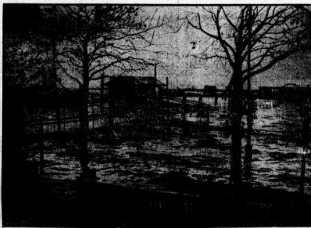
Sturmflutschäden im Nordseegebiet.
