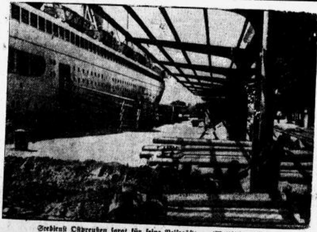
Seebienst Oberpreußen sorgt für seine Reisegäste. Die Trägerkonstruktion der neuen Schauhalle im Swinemünder Hafen.
