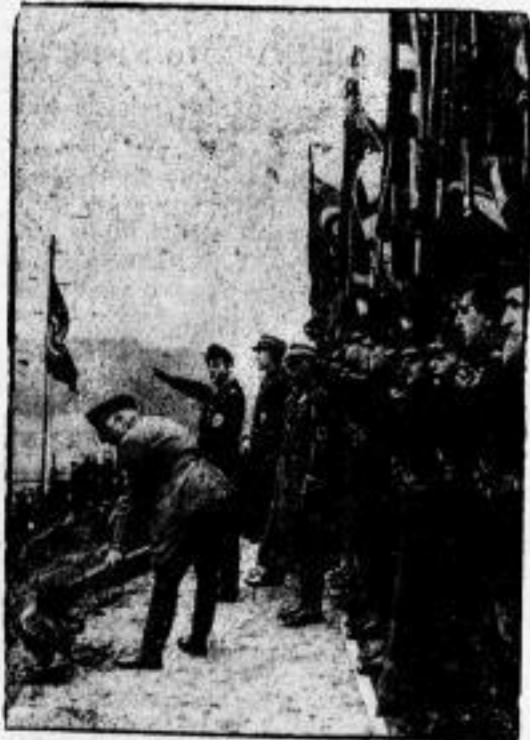
Gründungsarbeiten zum Bau von Betriebsportstätten. Reichsorganisationsleiter Dr. Ley beim ersten Spatenstich zum Bau eines Betriebsportplatzes auf dem Gelände des Deutschen Verlages in Berlin-Tempelhof. Die Gründungsarbeiten im Rahmen des Jahrestages der NSDAP „Kraft durch Freude“ war Mittelpunkt für etwa 100 Parallelveranstaltungen im Reich. Dr. Ley und der Reichsportführer (rechts) eröffneten das Übungsstättenbauprogramm der Betriebe. (Beitbild 1937).
