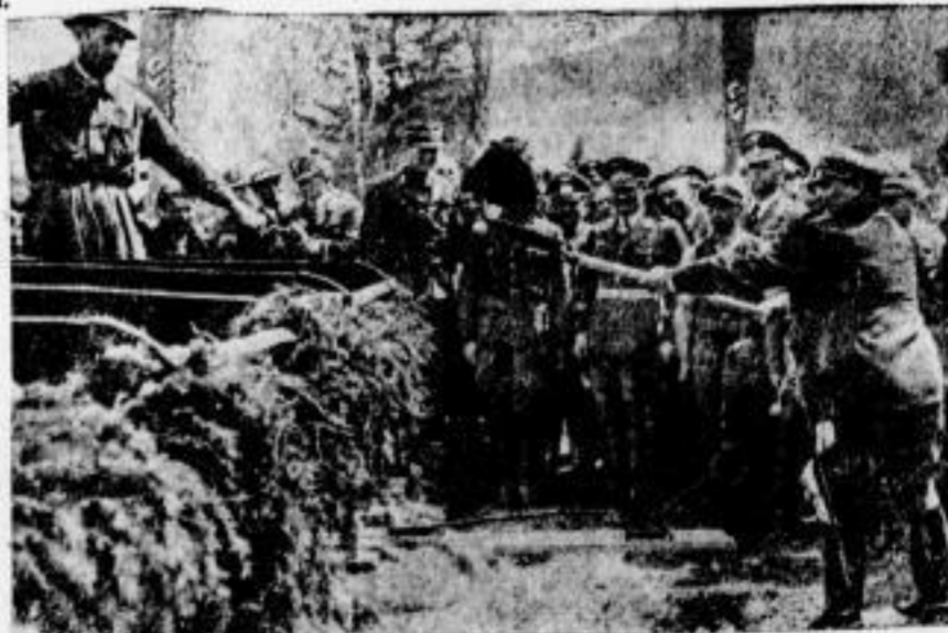
Bilder von der Aufbauarbeit in der Ostmark: Links: Der Führer beim ersten Spatenstich für die Reichsautobahn, daneben ein Ausschnitt von den Bauarbeiten am Wallenberg bei Salzburg, ein Riesensackler ebnet das Autobahngehänge. Rechts: Generalfeldmarschall Göring eröffnet mit dem ersten Spatenstich die Bauarbeiten für das riesige Leunertrostwerk. Reichskommissar Gauleiter Würdel gibt auf der 6. Reichstagung der Auslandsdeutschen in Stuttgart einen Heberblick über die bisher in der Ostmark geleistete Aufbauarbeit. Weidbild (M)
