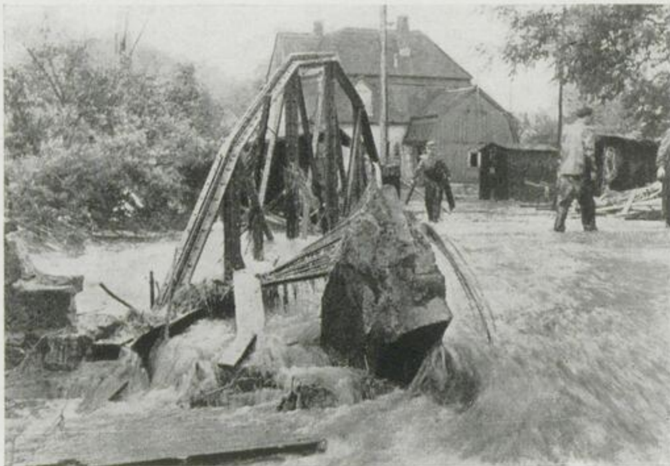
Wirkung des Hochwassers am 5. 7. 1958
