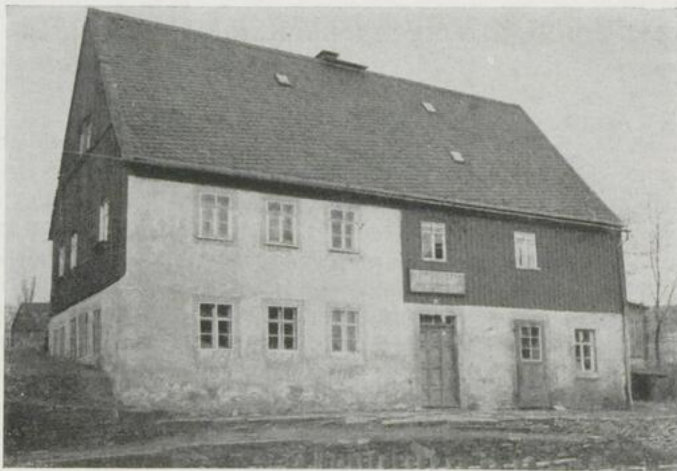
Ältestes Schulgebäude von Weißenborn, Dorfstraße 10
