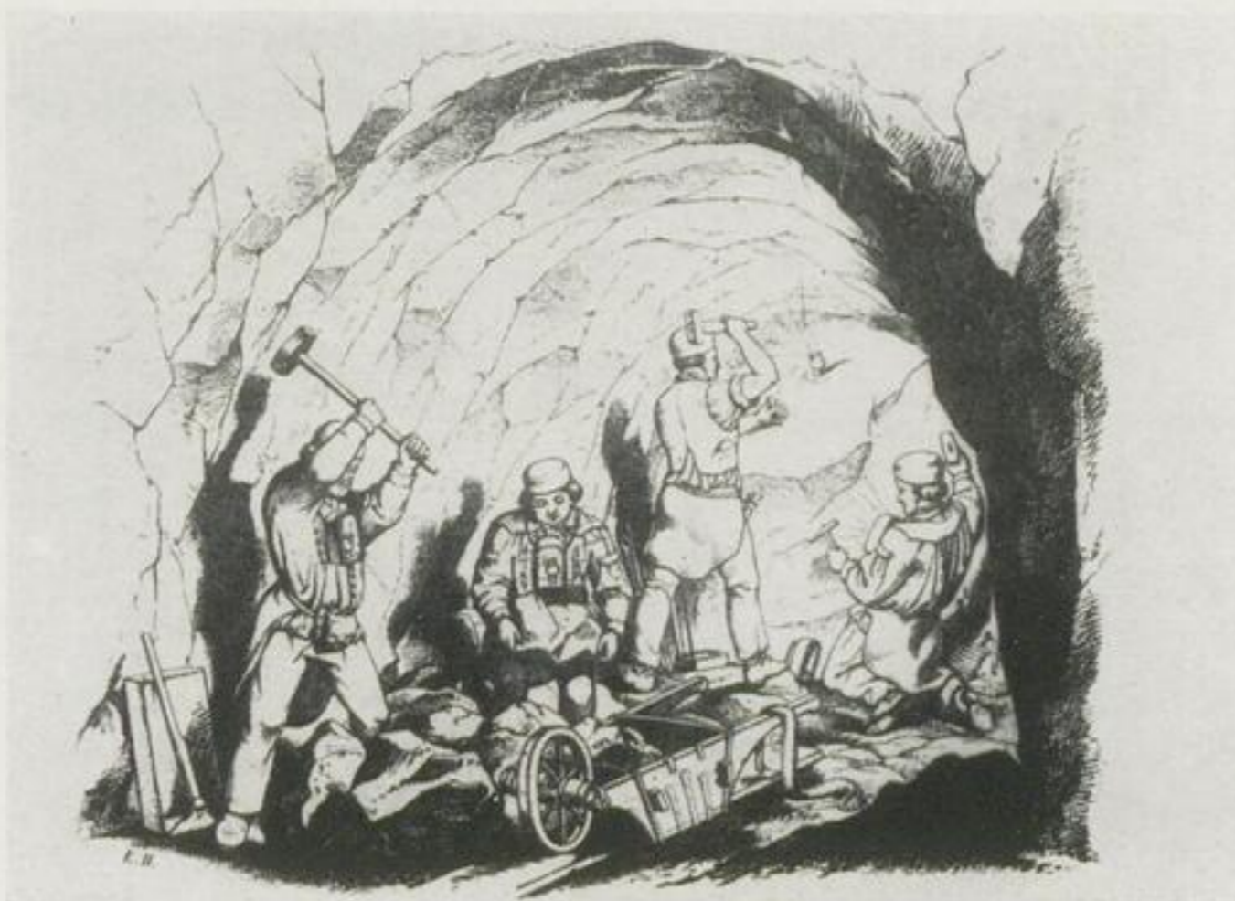
Arbeiten vor Ort
