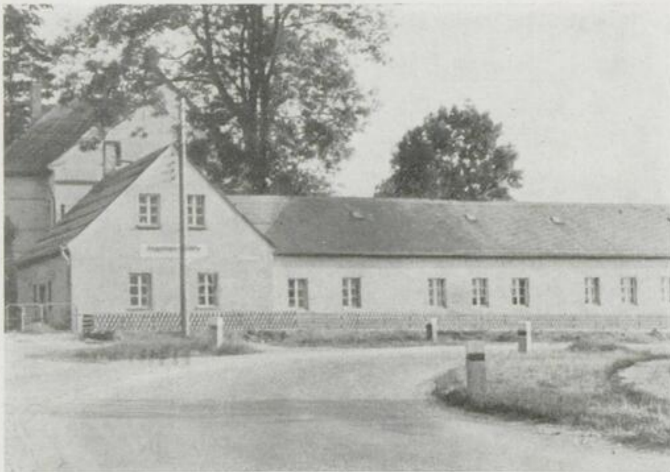
Erst Landarbeiterkate — jetzt Kegelbahn
