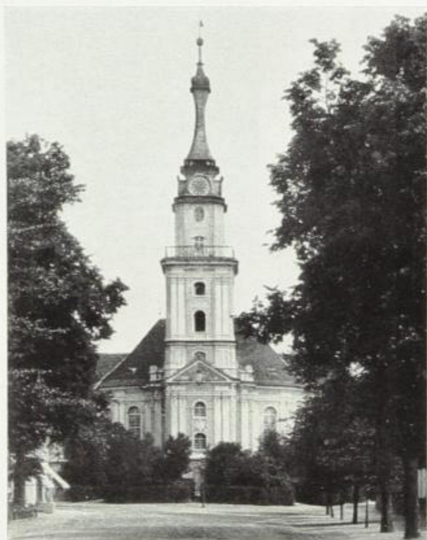
84. Carlsruhe (Oberschl.), Ev. Pfarrkirche
