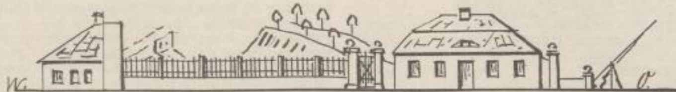
Nordansicht nach Niederlegung des äußeren Reichentores. Accise. Torhüterhaus.
