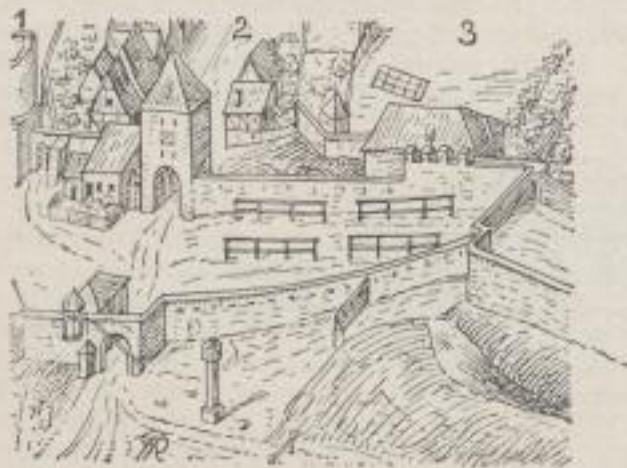
Neuheres Laurentore nach Schreiber. 1 Neutore. — 2 Laurentore. — 3 Bauhof. Aus „Bau- und Kunstdenkmäler“ von C. Gurlitt. Bild 26.
