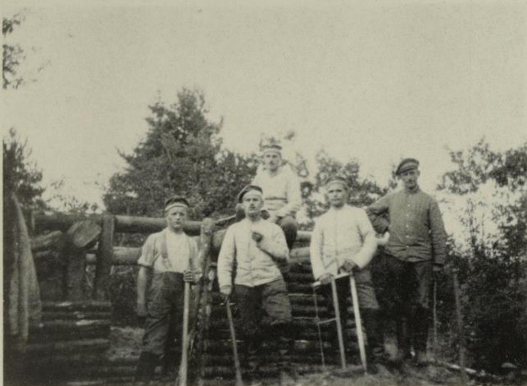
Bau eines Blockhauses in der Schile-Stellung, 5. Eskadron
