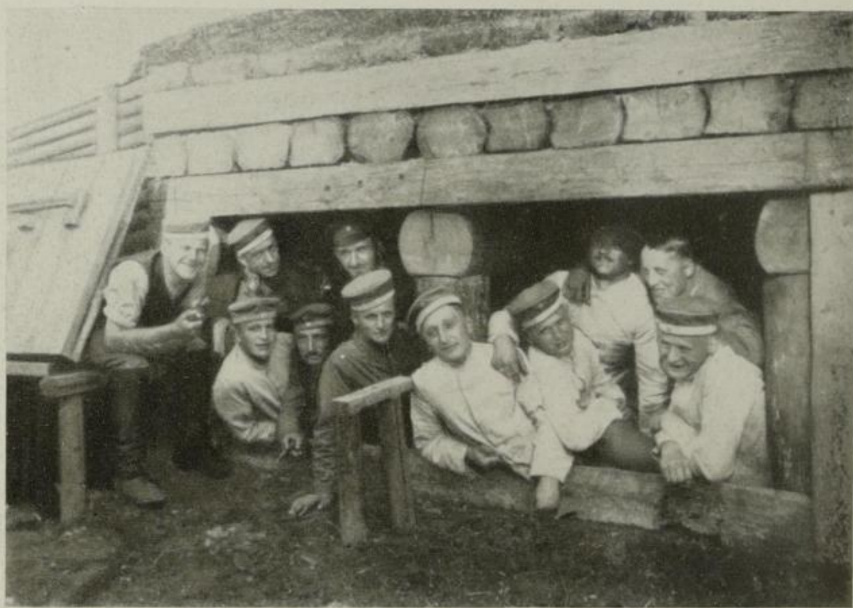
Schussicherer Unterschlupf der 2. Eskadron in der Schile-Stellung 1916
