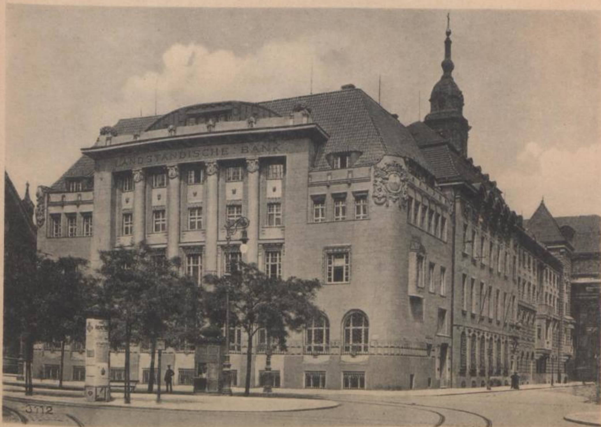
Landständische Bank in Dresden
