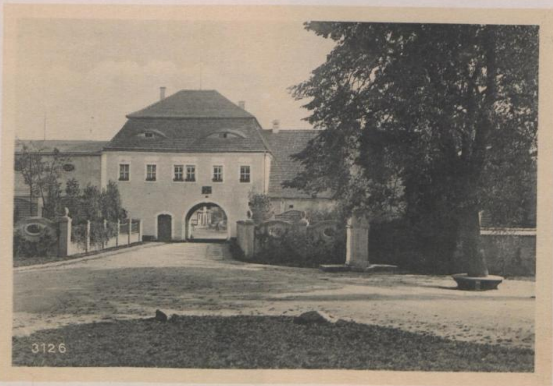
Einfahrtsplatz mit Brunnen
