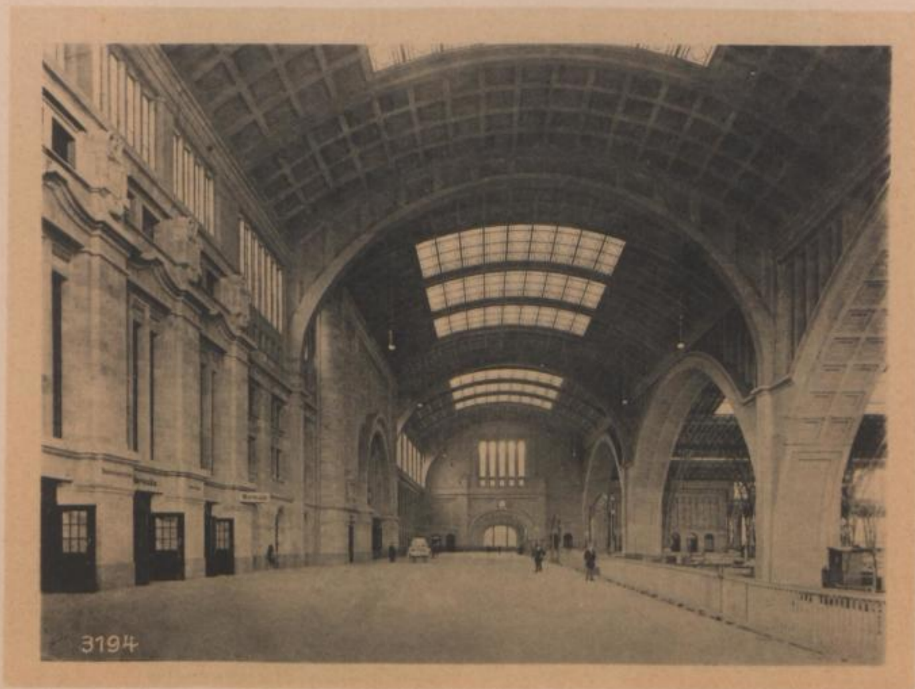
Querbahnsteig Hauptbahnhof Leipzig
