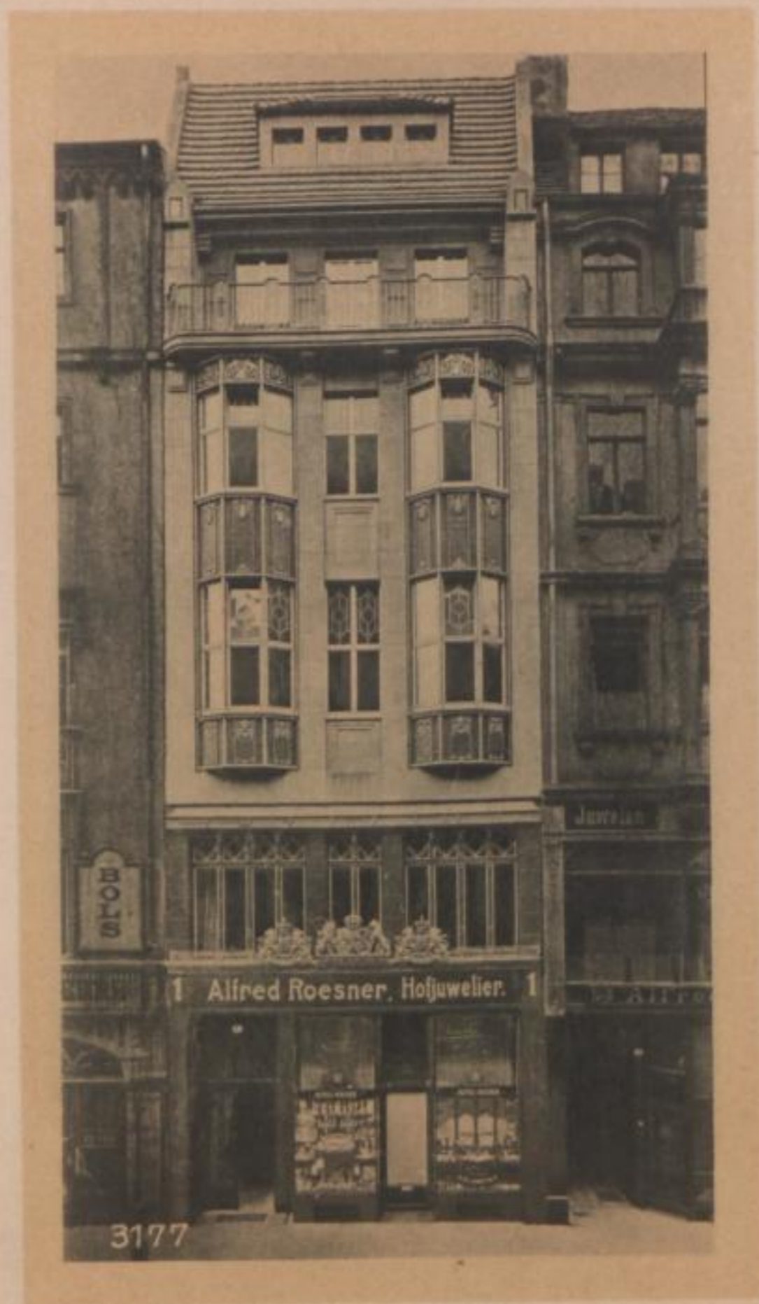
Geschäftshaus A. Roesner, Dresden
