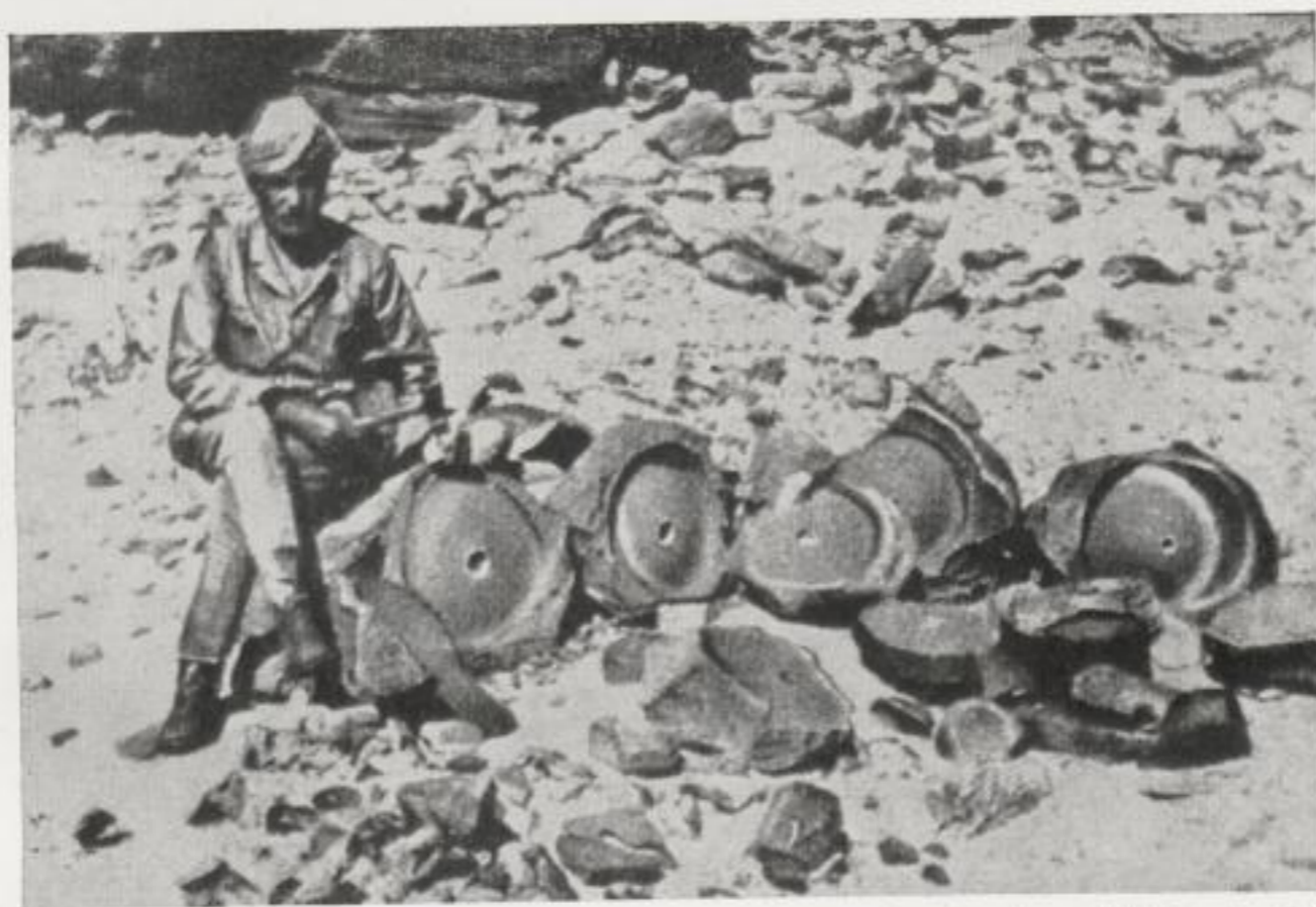
Abb. 4. Gesteinsmühlen zur Goldaufbereitung aus der Bischari-Wüste bei Schelläl
