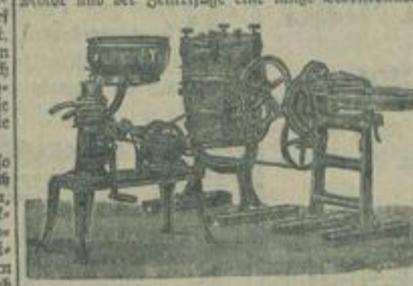
Wie aus der Abbildung ersichtlich, wird die Entzähnmotormaschine und der Motor von dem gleichen Motor getrieben wie die Zentrifuge, ein Vorteil, der ohne weiteres einsehbar ist. Man kann zu gleicher Zeit entzähnen, hüttern und breiten. Das wird aber in den wenigsten Fällen vorkommen. Man wird deshalb beim Hüttern oder Breiten den Pleinender hinhängen, das Seil für die Zentrifuge ab und umgekehrt.
