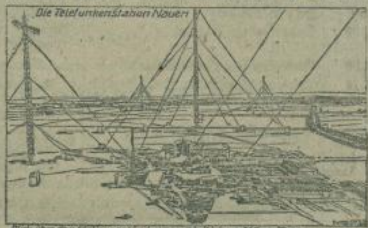
Blick über das Stationsgelände vom Südturm über den Turm.
