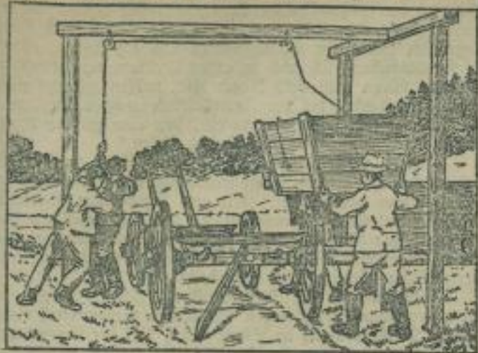
Absetzen der Wagenlasten.
