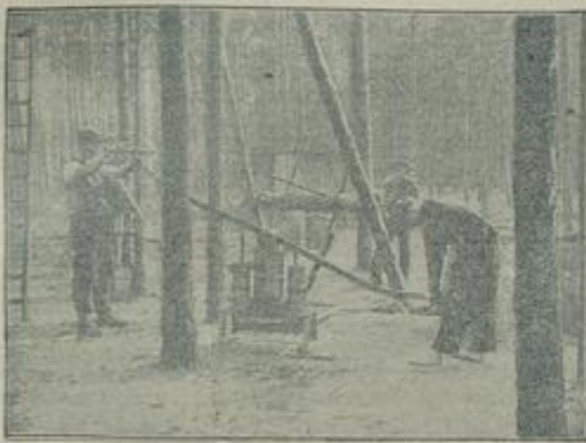
nommen hatte. Die Arbeiten werden zurzeit andauernd fortgesetzt, wie aus der obigen Aufnahme ersichtlich ist.
