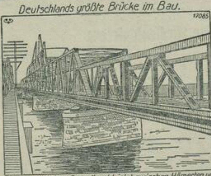
Nach zweijähriger Bauzeit geht jetzt zwischen Hämerten und Schönhausen die neue Elbbrücke ihrer Vollendung entgegen. Ihre Gesamtlänge beträgt 810 Meter.
