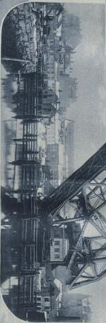
Oberes Bild: Schwefelfähre am Rieler Solen Bild rechts: Klappbrücke Stanton (Spannweite 40 Meter, Breite 10 Meter) über dem Stromfelsen-Ranal
