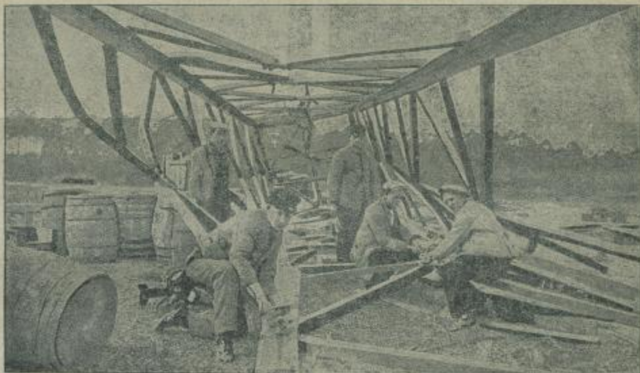
Der eingestürzte Funkturm bei Reesen.
