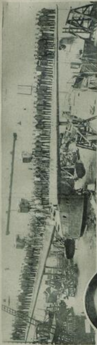
Das neue, Leinwand- flugzeug Holzbau- mauer, das größte deut- sche Orzenflugboot, bei der Belastungsprobe mit 97 Mann (D. P. P. Z.)
