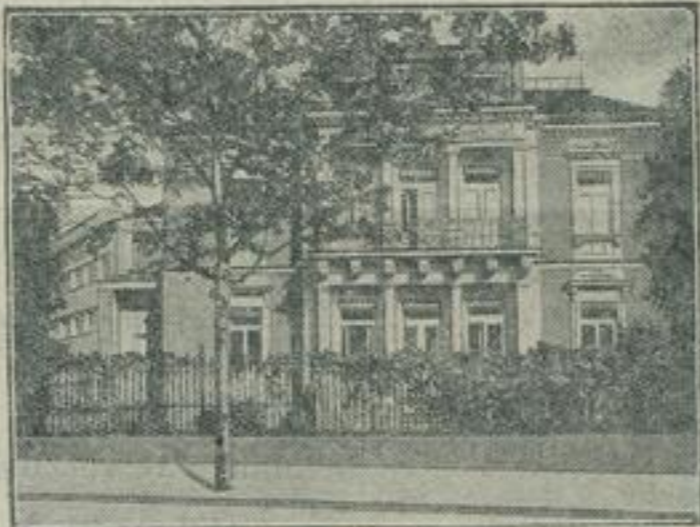
Das Haus der Wirtschaftshilfe der Deutschen Studentenschaft, das von der Stadt Dresden errichtet worden ist, wurde dieser Tage feierlich eingeweiht und eröffnet.
