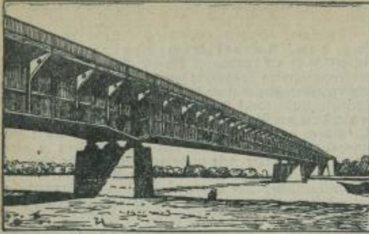
deren Bau im Frühjahr begonnen wird. Das Hauptloch der Brücke wird mit einer Spannweite von 110 Metern den Strom überqueren.
