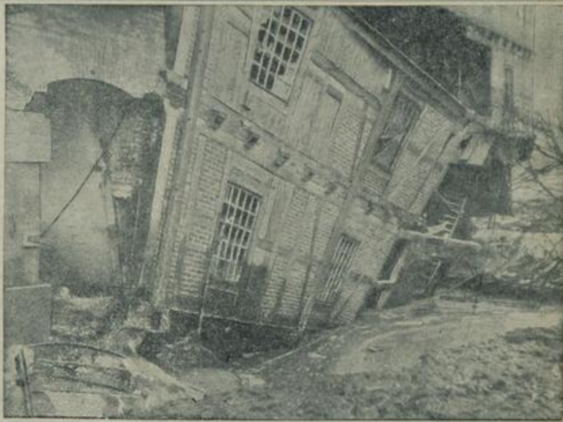
Eines der durch die Wassermassen völlig unterspülten Häuser in Strömsfjörð.
