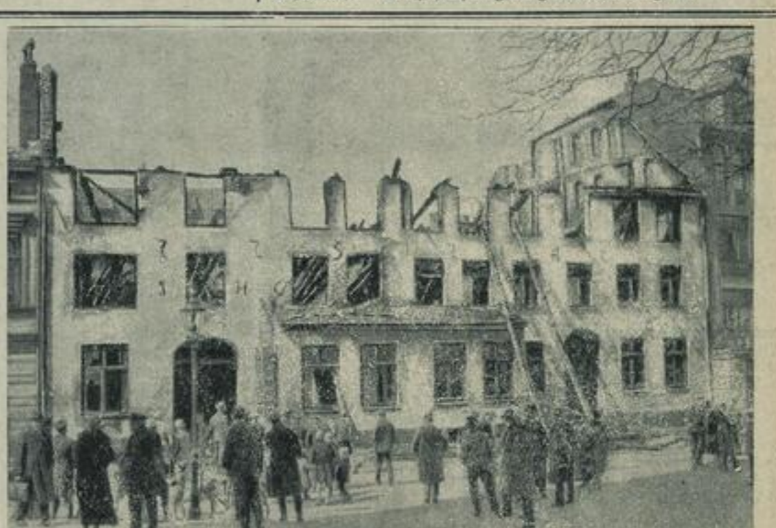
15. Mai vollständig stilllegen und hier 3200 Arbeiter entlassen müssen. — Bild rechts: Ein Großfeuer in Rostock vernichtete einen aus dem Jahre 1775 stammenden Getreidespeicher. Trotz der Bemühungen der Feuerwehr brannte das fünfstöckige Gebäude, dessen obere Stodwerke einstürzten, völlig aus.
