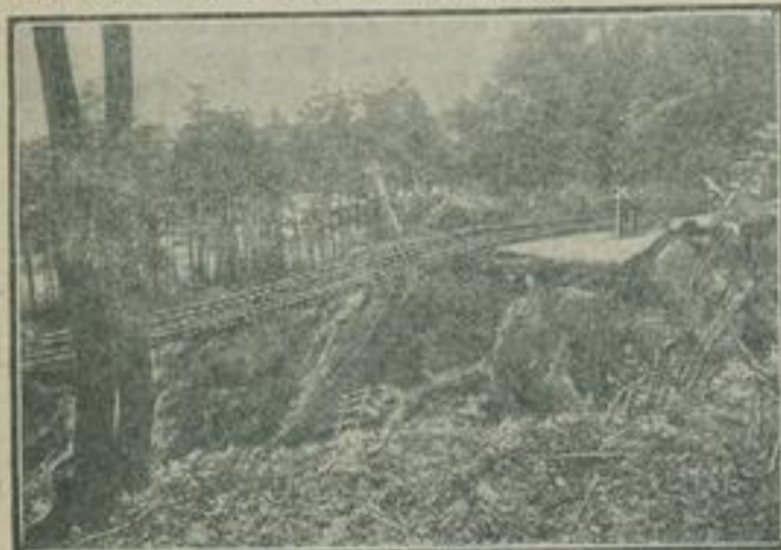
Wie eine Brücke hängen die Eisenbahnschienen über der Tiefe des Trichters.
